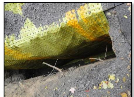
Après avoir placé le BIOBARRIER dans le tranché tout en s'assurant de garder un excédant de 12" à la surface du sol, la terre de remblais fut placée dans le tranché en mettant l'argile au fond.
