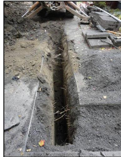
*Afin de positionner le BIOBARRIER jusqu'au fond du tranché, un morceau de bois de 1" x 2" fut attaché à une des extrémités du BIOBARRIER.*
