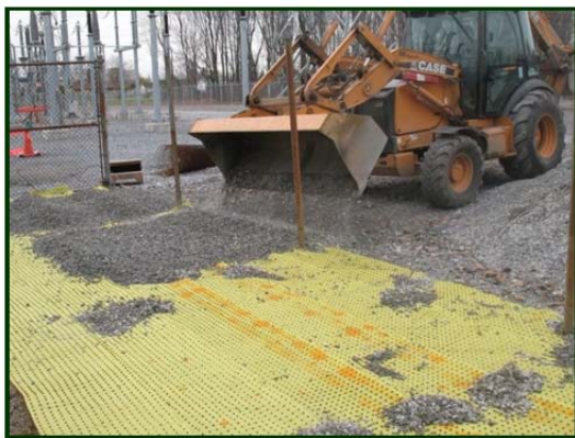
Une épaisseur de 3" de pierre est déposée sur Biobarrier.
