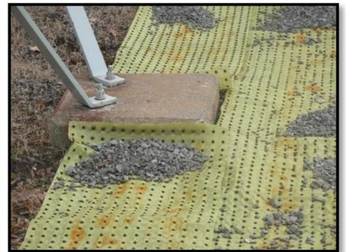
*Une épaisseur de 3" de pierre est déposée sur Biobarrier.*
