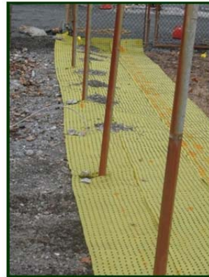
Mise en place du Biobarrier en superposant chaque membrane par deux nodules de plastique.
