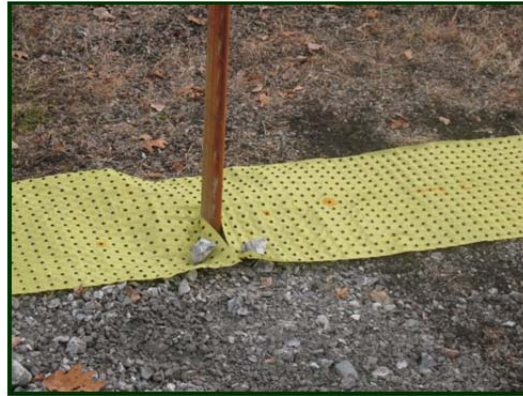
Biobarrier se conforme très bien au poteau de métal.
