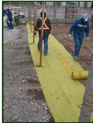
Mise en place du Biobarrier en superposant chaque membrane par deux nodules de plastique.
