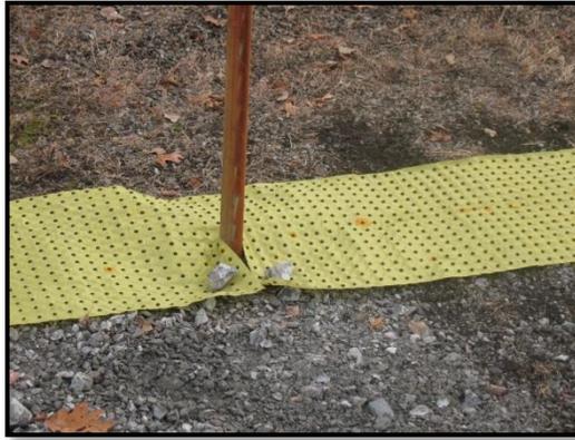
*Mise en place du Biobarrier en superposant chaque membrane par deux nodules de plastique.
