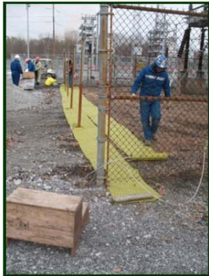
Mise en place du Biobarrier en superposant chaque membrane par deux nodules de plastique.
