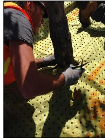
**Afin de sécuriser Biobarrier en place, des attaches de plastiques fournies avec chaque rouleau ont été placées.**
