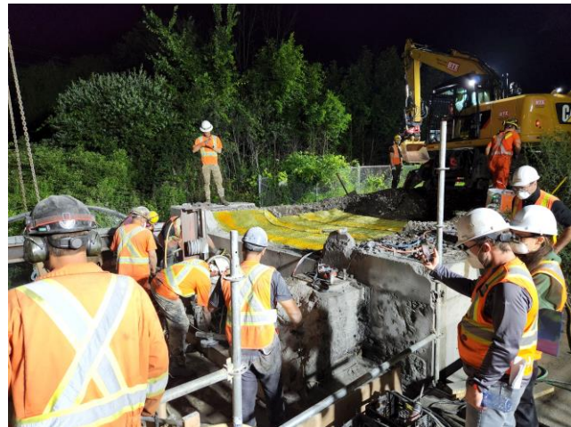
Mise en place du Typar Biobarrier
