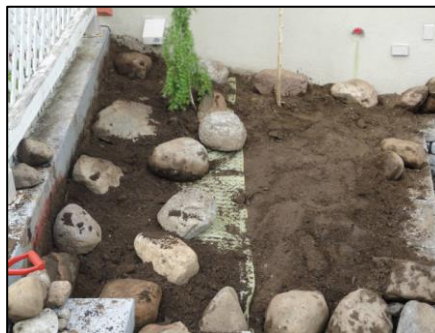
Mettre 2" à 3" de terre sur la surface.
