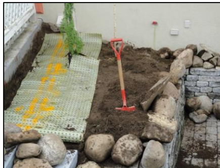
Dérouler le Biobarrier et entourer l'arbre tel que démontré.
