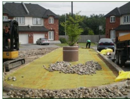
Vue d'ensemble après l'installation du Biobarrier. Mise en place de la pierre.
