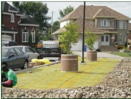
Vue d'ensemble après l'installation du Biobarrier. Mise en place de la pierre.
