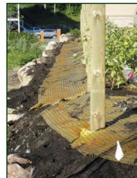
*Mise en place de la tourbe et du paillis autour des arbres et des arbustes. Le recouvrement total sur Biobarrier ne devrait pas excéder 3”.*
