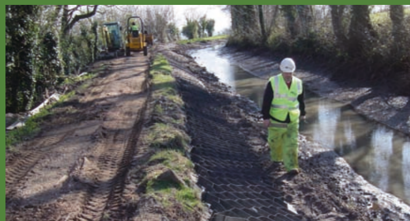
Stabilisation de rive de canal, Royaume-Uni
