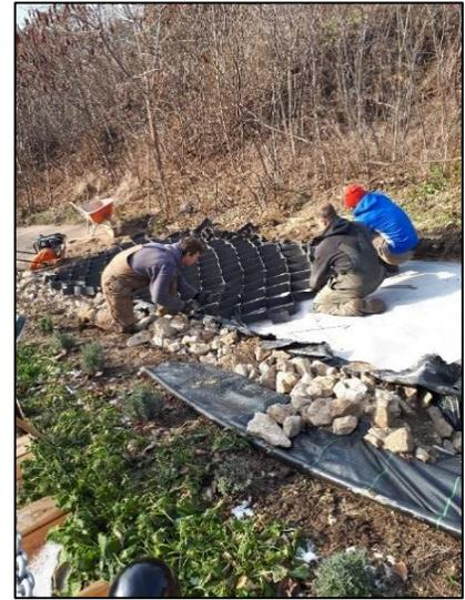
*Remplissez les cellules de Typar Geocells de sable/pierre concassée et ancrer avec les J-pins de 21".*
