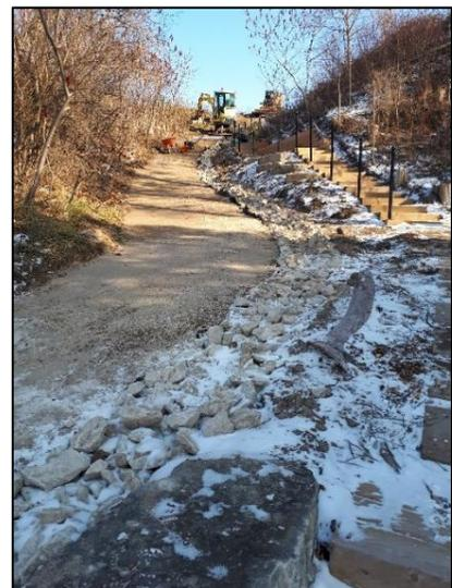
*Déployer le Typar geotextile et placer le Typar Geocells sur le dessus.*
