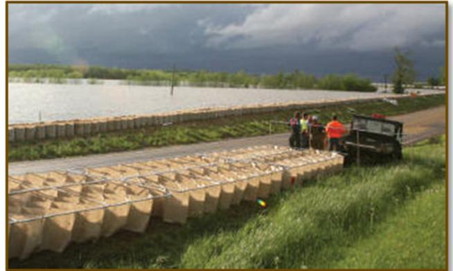
Cette installation représente le plus important projet pour Defencell aux U.S.A. Defencell est un géotextile de marque TYPAR dont les cellules sont remplies avec du sable. L'installation se fait très rapidement et avec une main d'œuvre très restreinte.
